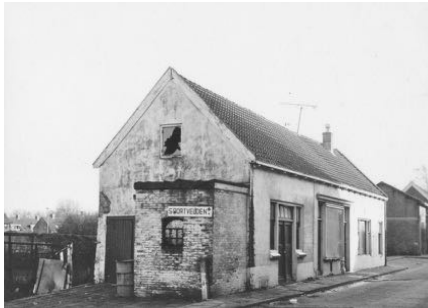
De slachterij, slagerij en woonhuis van Schouten in vervallen staat, ca 1970.
