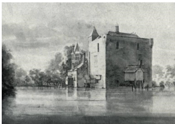
Slot "Valckesteijn", gebouwd rond 1310.
